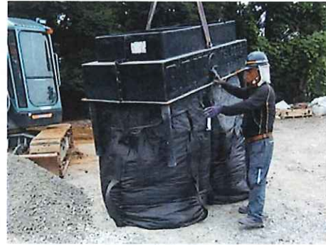
治具本体の引き上げ
